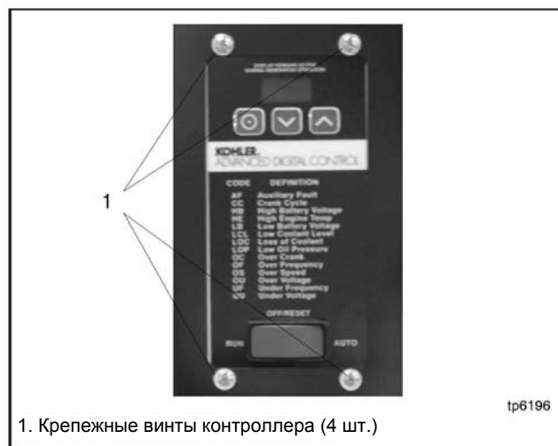
Рисунок 6-1 Крепежные винты контроллера ADC 2100
