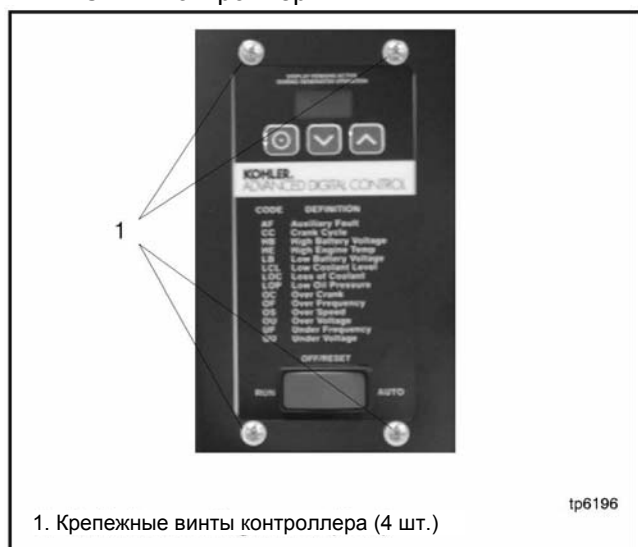
Рисунок 9-2 Крепежные винты контроллера ADC 2100
